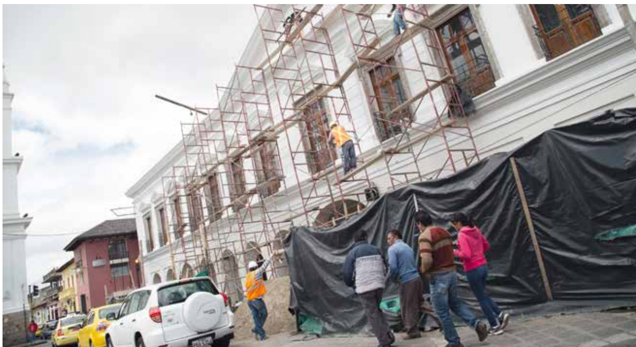
Remodelación patrimonial del edificio de la Gobernación de Cotopaxi
