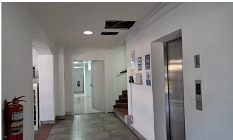
Ilustración 12: Pintura en pasillo de ingreso
