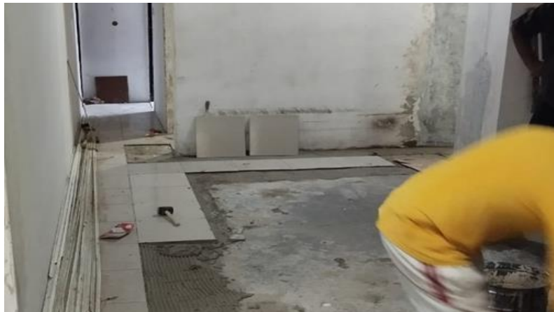
Ilustración 10: Trabajos en área externa de archivo (contrapiso)
