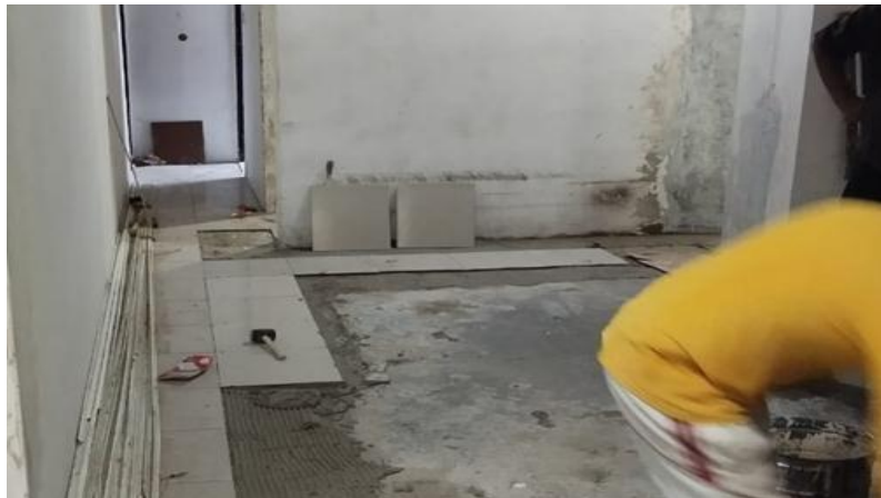
Ilustración 10: Trabajos en área externa de archivo (contrapiso)
