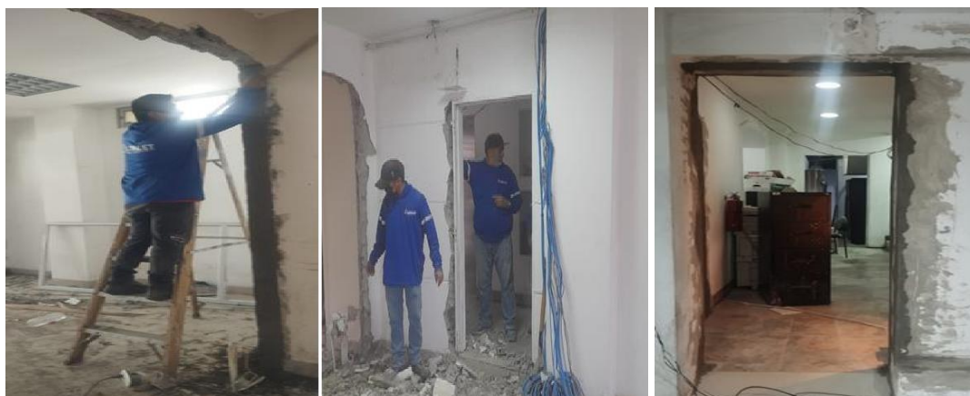
Ilustración 9: Trabajos en sellado de boquete de puerta y apertura de nuevo ingreso
