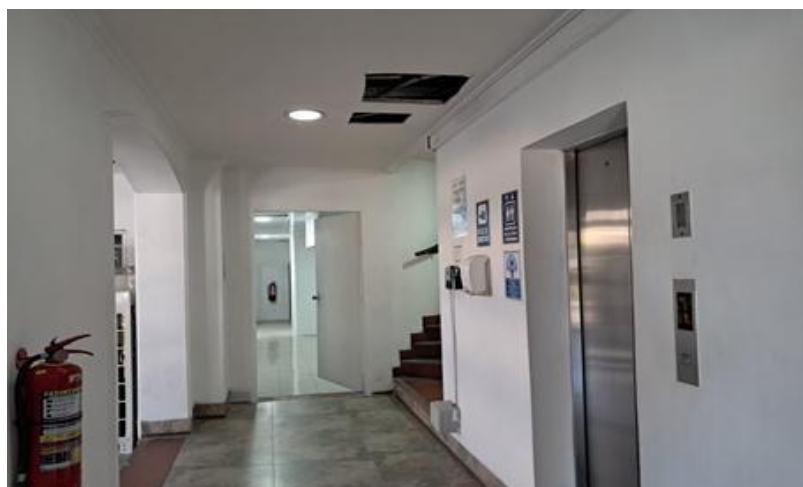
Ilustración 12: Pintura en pasillo de ingreso
