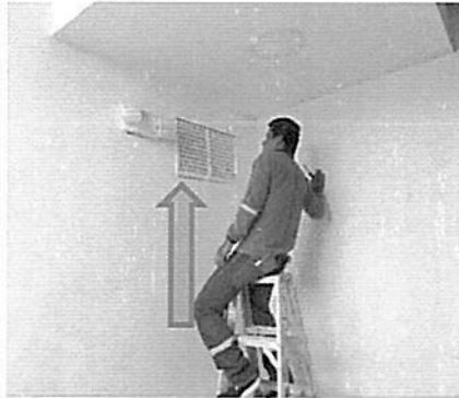
Rejillas inadecuadas en las gradas de presurización de gradas
