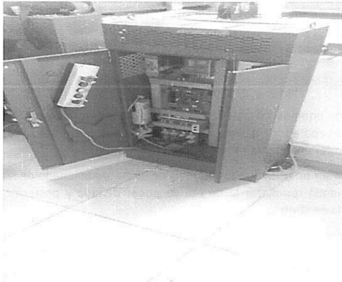
Calibrando los ascensores e instalando los 2 citofonos Fotografías No. 12
