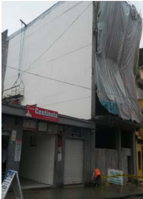
FACHADA FRONTAL DE LA CALLE DIEGO DE VACA
