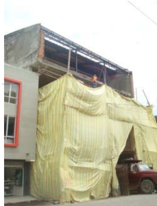
FACHADA POSTERIOR DE LA CALLE SEVILA DE ORO
